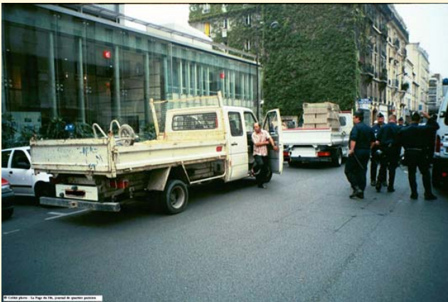
Arrivée du sable, ciment et parpaings
